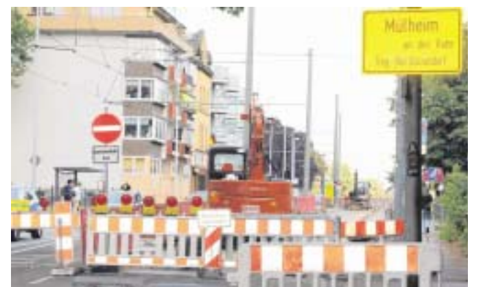
Sie bleibt eine Baustelle: die Duisburger Straße.
